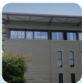
E2C 64 - Site de Bayonne 24 chemin Sabalce Espace Arena - Porte 84A 64100 BAYONNE
